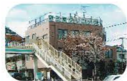
以前の三家クリニック 改装後(平成23年)は4階建てに
